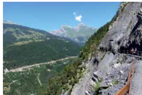
Bisse du Torrent Neuf (photo : LOST)
