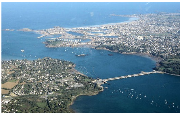
Vue aérienne de la Rance
