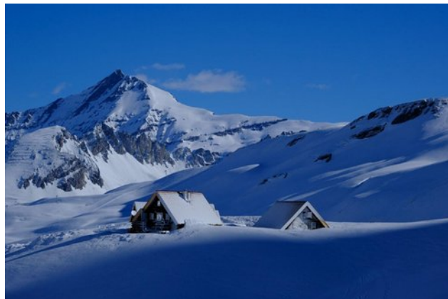
Refuge du Fond des Fours en hiver (source refuge du Fond des Fours)
